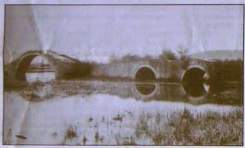
Το γεφύρι του Καλόγηρου! Είναι φωτογραφημένο από τέτοια οπτική γωνία, που γίνεται πια αντιληπτή η αληθινή, η πλήρης μορφή του.
